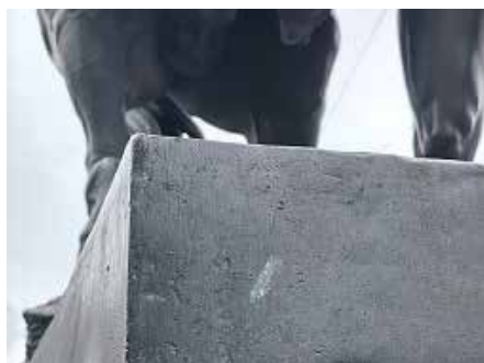
Ил. 7. Фотографии скульптурной группы с покрытием, нанесенным методом ХГН, при визуальном осмотре. Фото авторов
